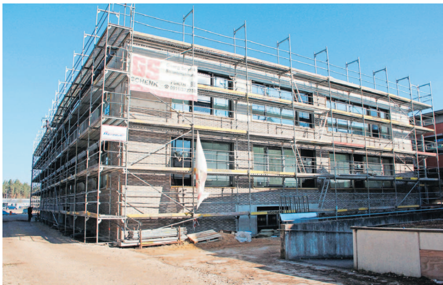
Der Neubau für die Anton-Seitz-Schule nimmt Gestalt an. Auch in Form der Kosten: Für 2018 stehen 3,2 Millionen Euro im Haushalt, den der Stadtrat jetzt vorberaten hat. Insgesamt kostet der Anbau 10,1 Millionen Euro. Foto: Carola Scherbel
